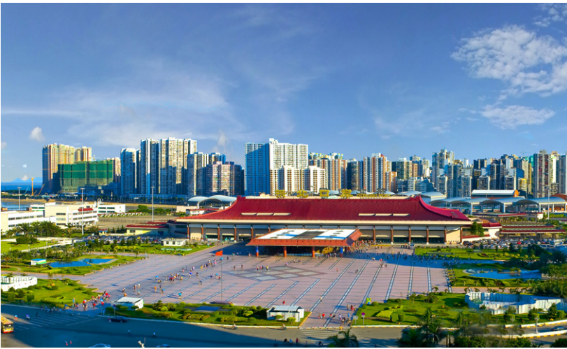
拱北口岸通关大厅改扩建工程
