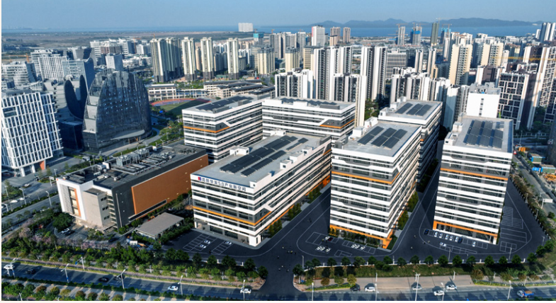
华发智造产业园屋顶光伏项目
